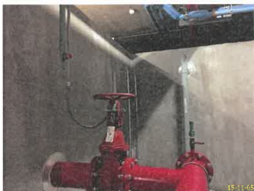
ระบบน้ำสำรองดับเพลิง และระบบจ่ายน้ำดับเพลิง ระบบป้องกันเพลิงไหม้ ภาพที่ 2.2-18 (ต่อ) ระบบป้องกันและเตือนอัคคีภัย
