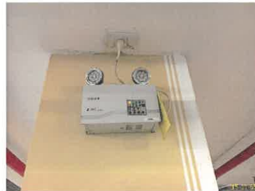
ระบบจ่ายพลังงานสำรอง ภาพที่ 2.2-18 (ต่อ) ระบบป้องกันและเตือนอัคคีภัย
