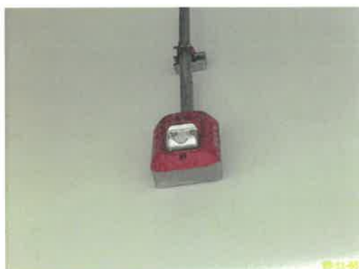
ปุ่มกดแจ้งสัญญาณอัคคีภัย และอุปกรณ์ส่งเสียงสัญญาณแจ้งเหตุ ระบบตรวจสอบและแจ้งเหตุเพลิงไหม้ ภาพที่ 2.2-18 ระบบป้องกันและเตือนอัคคีภัย
