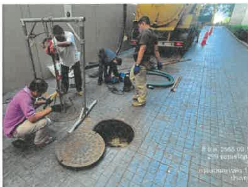
ภาพที่ 2.2-12 สูบตะกอน และดักไขมันระบบบำบัดน้ำเสีย
