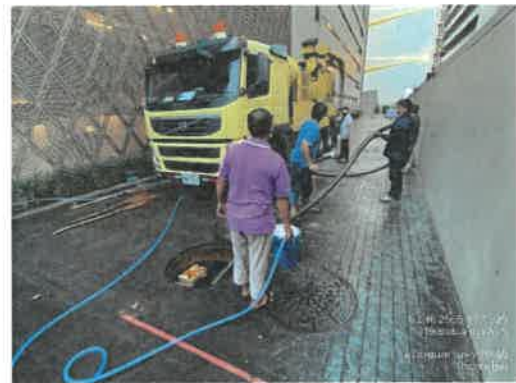
ภาพที่ 2.2-12 สูบตะกอน และดักไขมันระบบบำบัดน้ำเสีย
