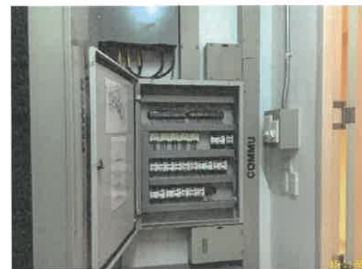
ภาพที่ 2.2-22 ระบบไฟฟ้าฉุกเฉินหน้าห้องพัก
